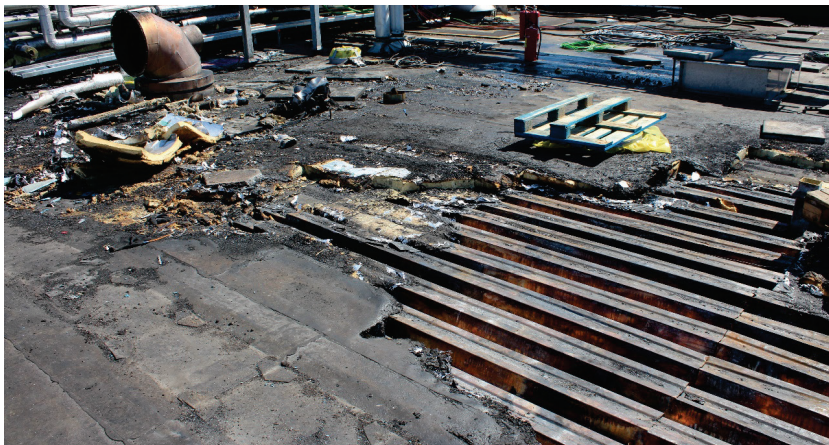
Figur 5: En del af det brændte tag.
