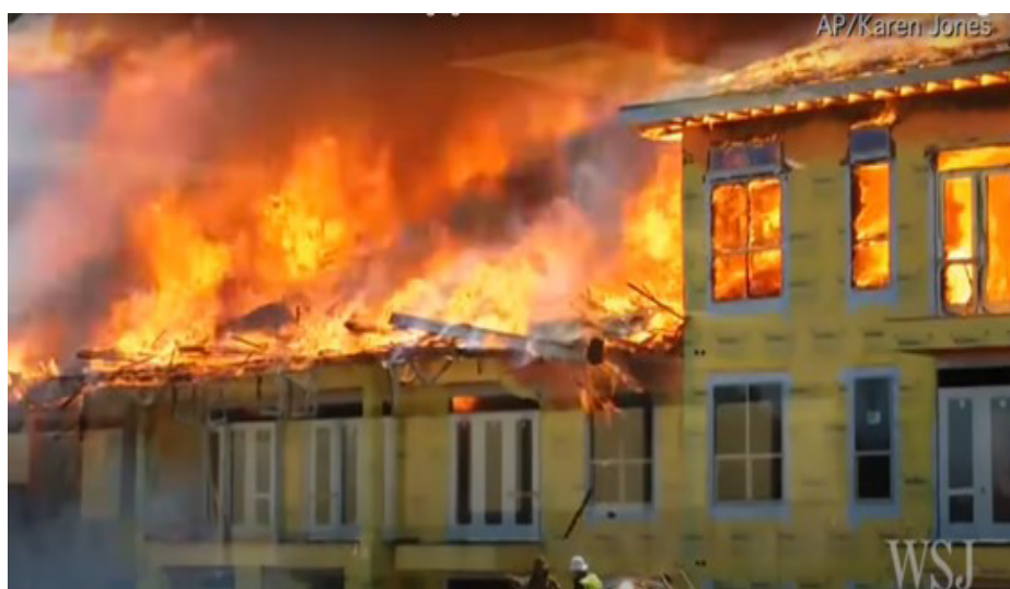
Figur 8. Exempel på brand i cellplast i New York (Källa: The Wall Street Journal).
