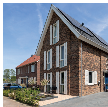
14 Het Burgje in Odijk
