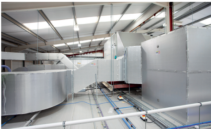
Het Kingspan KoolDuct® Systeem geïnstalleerd op een verlaagd plafond met beperkte plafondruimte.
